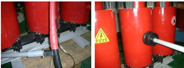
a. UHF 磁場耦合模式 b. 電場耦合模式
