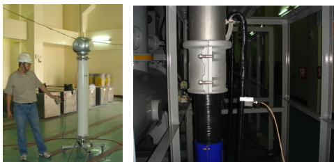
(a) 耦合電容 (b) UHF 感測器
