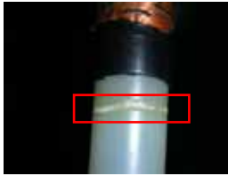
(c)剝除(b)電纜終端後
