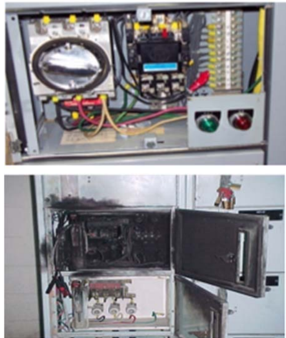
圖3 480V的馬達控制盤為電弧閃絡事故的常見盤型
